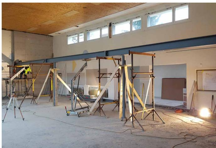
Montage von Stahlträgern für den Einbau der Galerie
